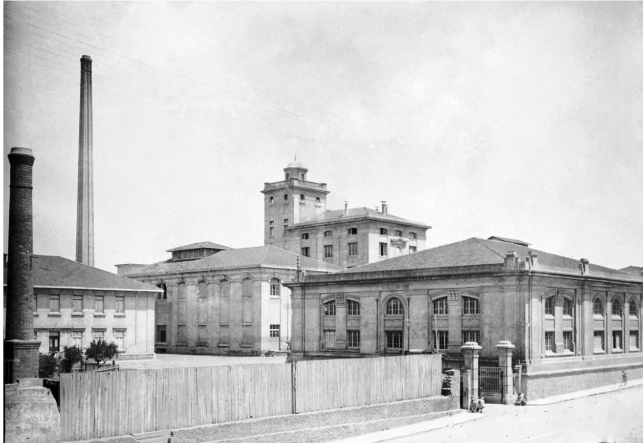
A unidade fabril “Estrella”, fundada na Avenida Sacadura Cabral, no ano de 1923.
