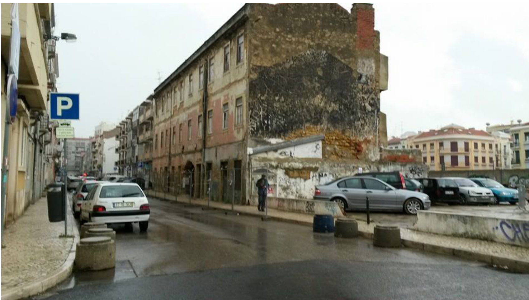
A vila Antunes construída atrás do prédio número 77 fotografia de Aquilino Machado, 2013
